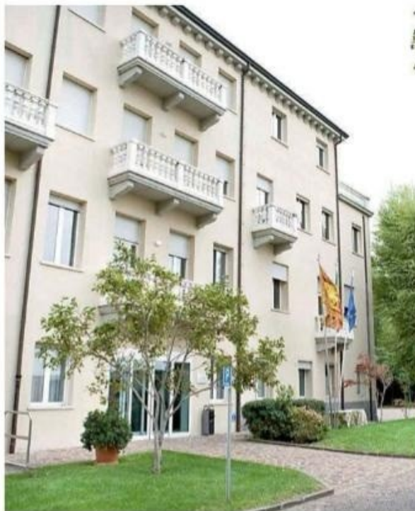
L'ingresso dell'ospedale San Camillo, agli Alberoni
