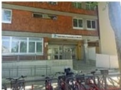
L'ingresso Il distretto dell'Usl in via Cappuccina a Mestre, dove ora ha aperto anche la nuova casa della Comunità
